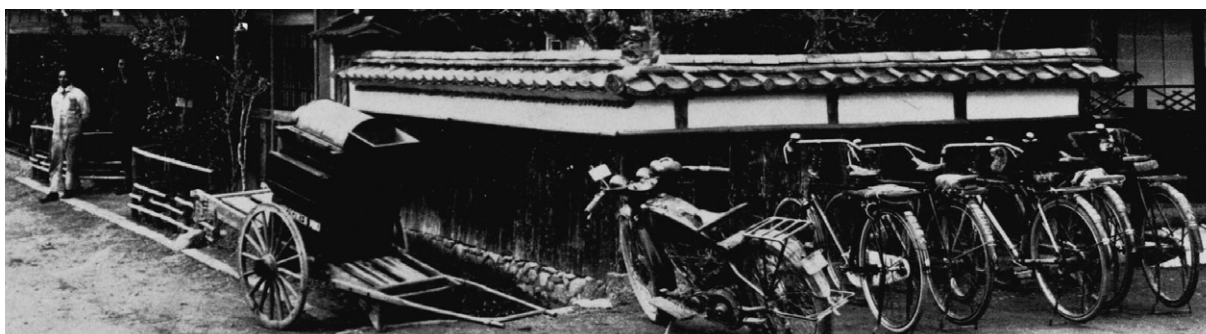
工場入口 昭和7年
